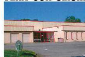
LEGENDRE Vente du bâtiment. 7 400 m 2
