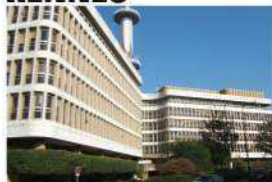
LEGENDRE Ancien immeuble de bureaux de France Telecom. 17 000 m 2 La Mabilais
